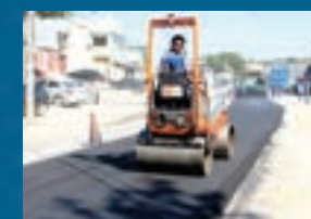
Obra na Est. de Sepetiba
