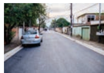
Depois das Obras
