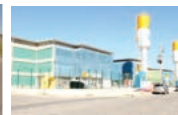
Complexo Escolar Nova Sepetiba - DEPOIS
