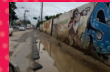
Estrada do Piaí - ANTES
