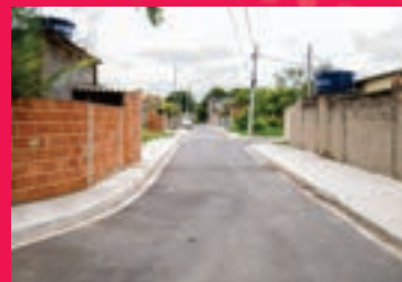
Depois das Obras
