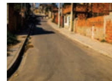
Depois das Obras
