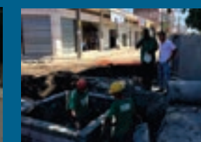
Obra de saneamento na rua Pedro Leitão em Sepetiba
