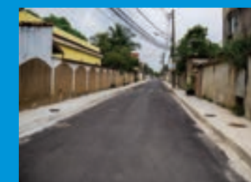
Depois das Obras
