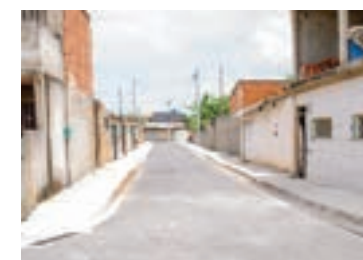
Depois das Obras
