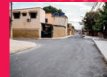
Depois das Obras
