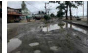
Praia de Sepetiba - ANTES DA OBRA
