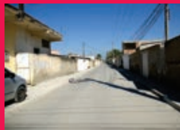
Depois das Obras
