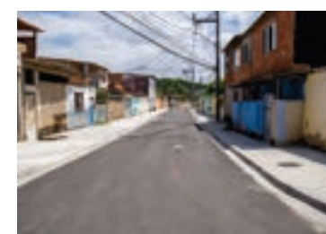
Depois das Obras
